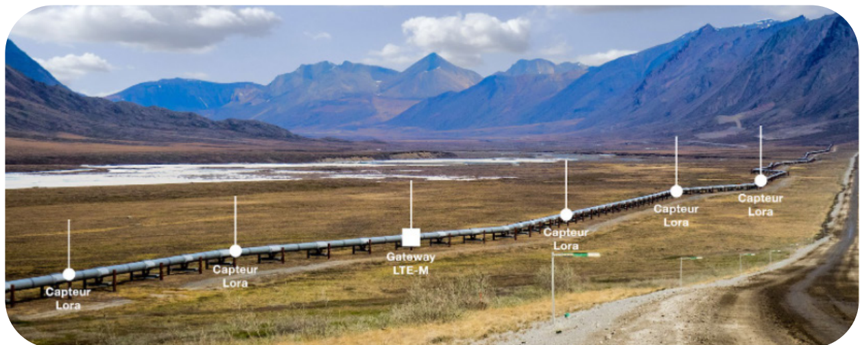
Un gazoduc utilisant les technologies LoRa et LTE-M
